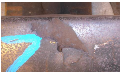
Figura 15. Desintegração da superfície de rolamento
