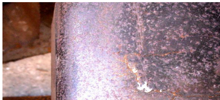
Figura 10. Fenda horizontal.
