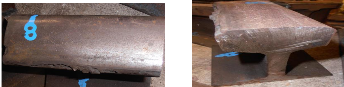
Figura 16. Imagem A: Descascamento lateral da cabeça do carril: vista superior. Imagem B: Descascamento lateral da cabeça do carril: vista em perfil
