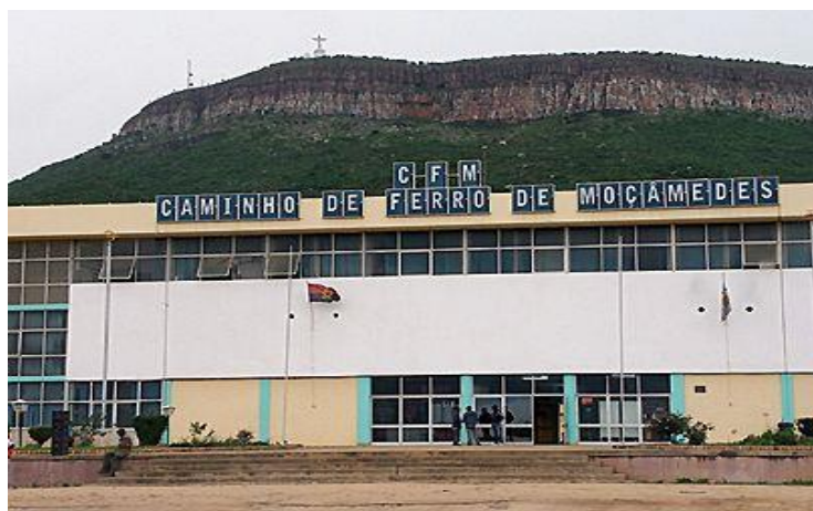
Figura 22. Empresa Caminhos-de-ferro de Moçâmedes. Estação do Lubango
