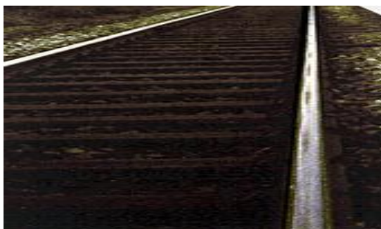
Figura 12. Carril com desgaste de onda longa
